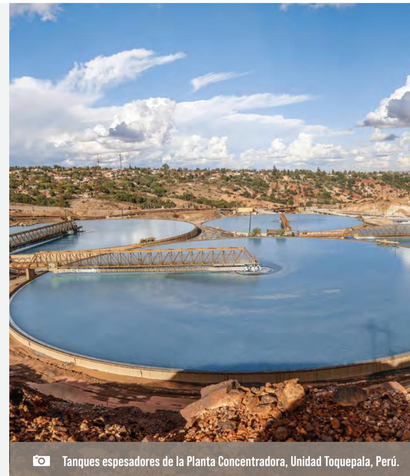
Tanques espesadores de la Planta Concentradora, Unidad Toquepala, Perú.
