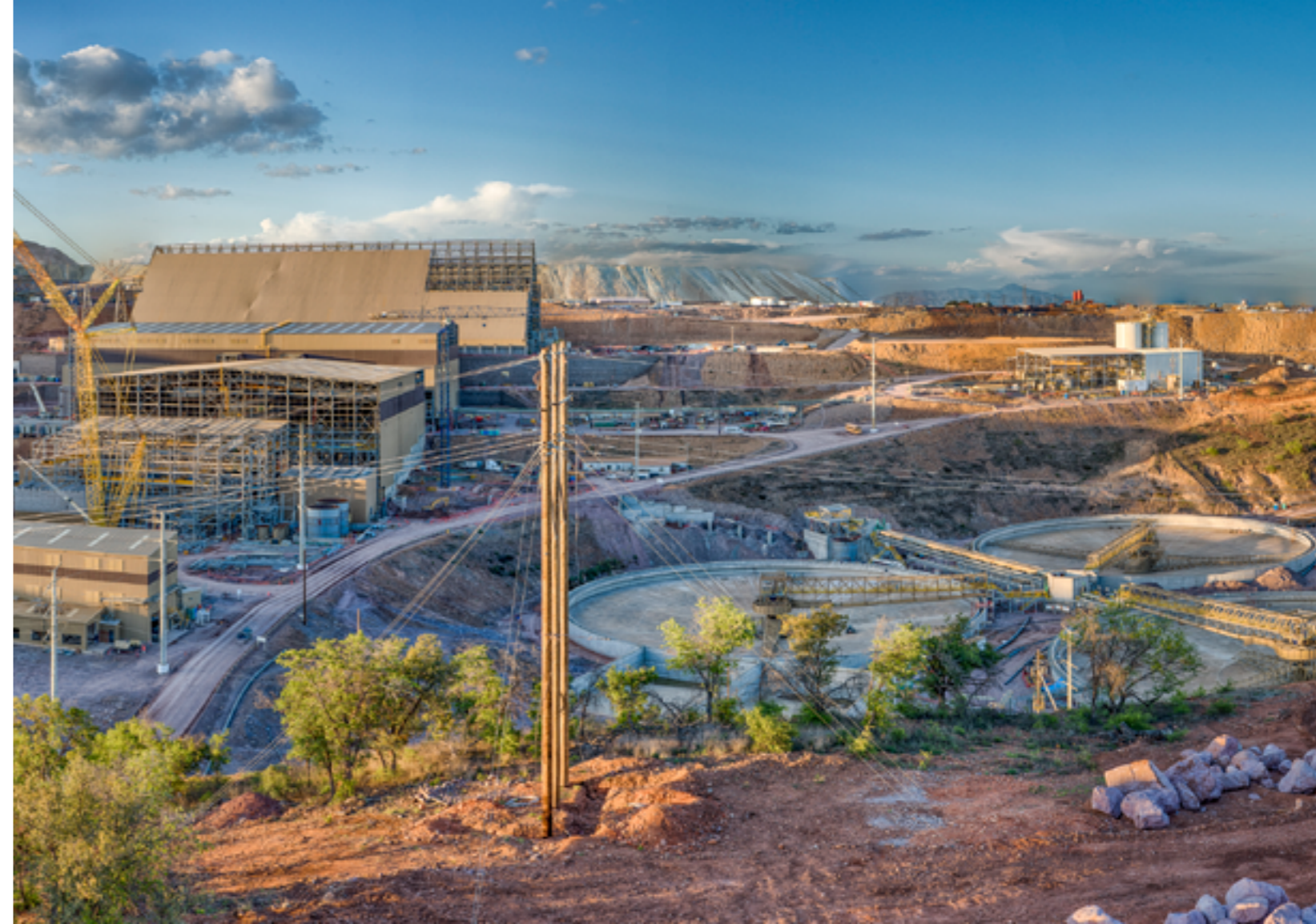
Construcción de la Concentradora II en Buenavista del Cobre, Sonora, México.
