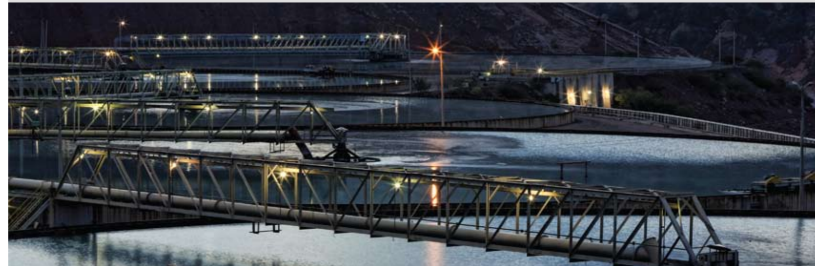
Los espesadores de jales en la planta de beneficio de "La Caridad", Sonora, ayudan a recuperar más del 80% del agua que consumimos en el proceso.
