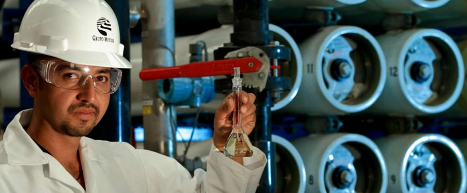
Planta de tratamiento de aguas residuales, San Luis Potosí.
