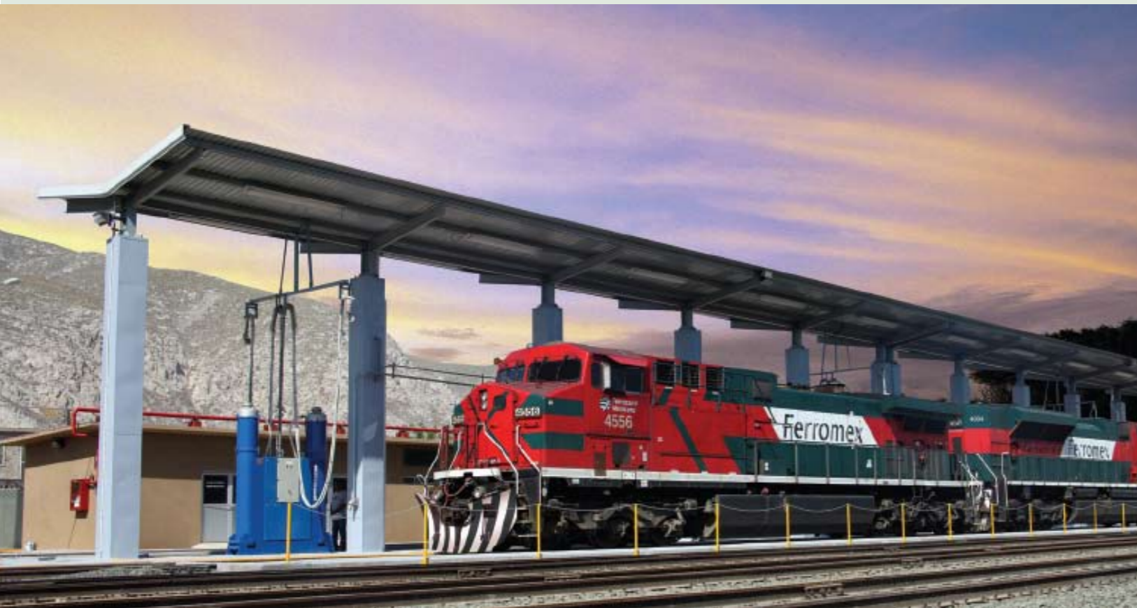
Zona de abastecimiento en Torreón, Coahuila.
