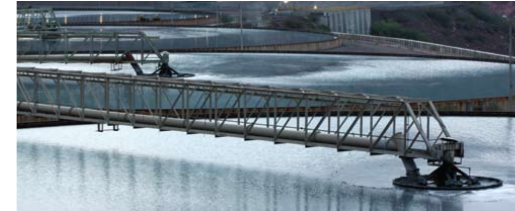
Espesadores de alta tecnología que nos permiten un aprovechamiento eficiente del agua.
