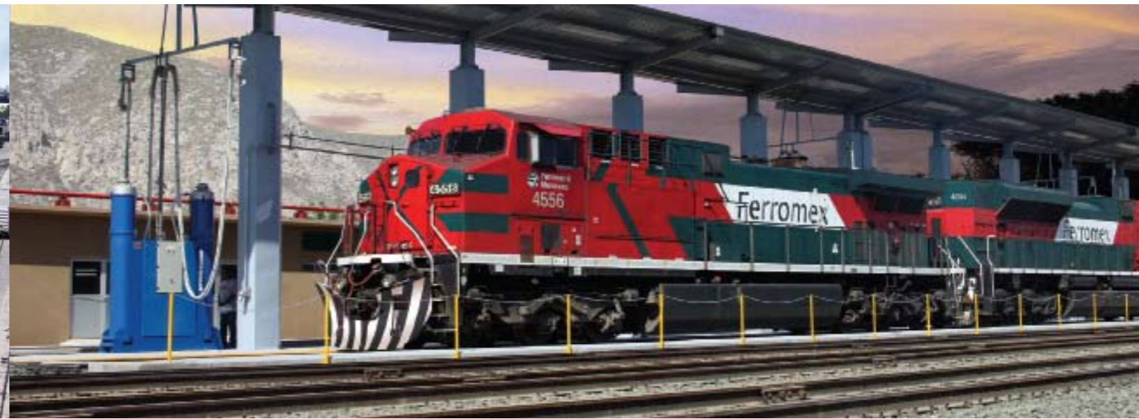
Zona de Abastecimiento en Torreón, Coahuila, con capacidad para 1,200 servicios mensuales. Puede surtir 8,150 m³ de diesel y atender a cuatro locomotoras al mismo tiempo; cuenta con ocho posiciones de despacho. Fue construida en 2008 con una inversión de 67 millones de pesos.
